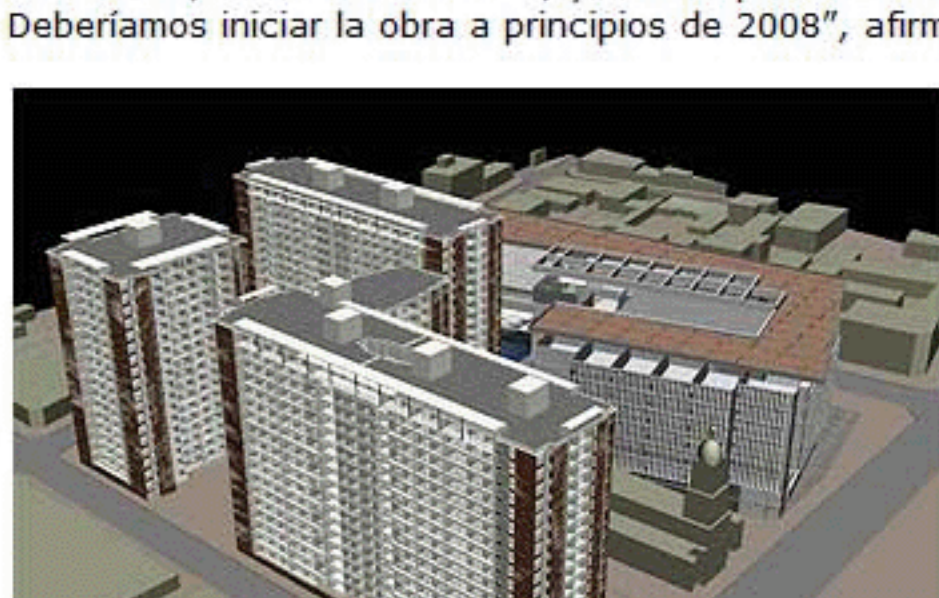
RECOLETA. Ubicado en los terrenos del ex Liceo Alemán, Altos de San Cristóbal considera una inversión de UF 700 mil, sólo en edificación, y esperan ventas por UF 1 millón 850 mil.
