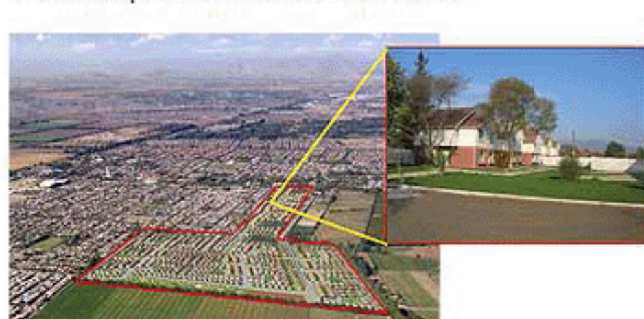
PADRE HURTADO. Esta zona se convirtió en una alternativa a la habitada comuna de Maipú. Aquí Banmerchant está iniciando la segunda etapa de su proyecto Valle El Trébol, que contempla la construcción de 1.300 casas.
