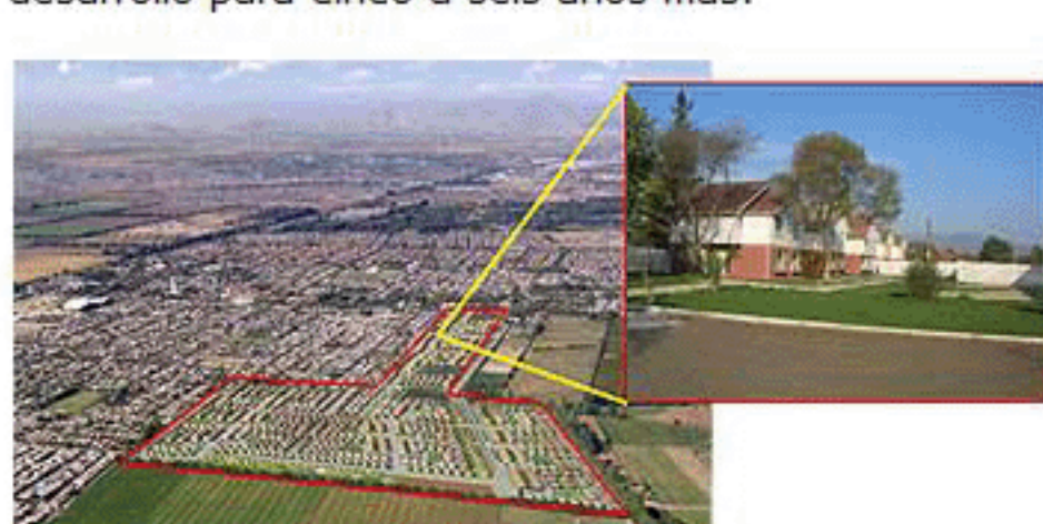
PADRE HURTADO. Esta zona se convirtió en una alternativa a la habitada comuna de Maipú. Aquí Banmerchant está iniciando la segunda etapa de su proyecto Valle El Trébol, que contempla la construcción de 1.300 casas.
